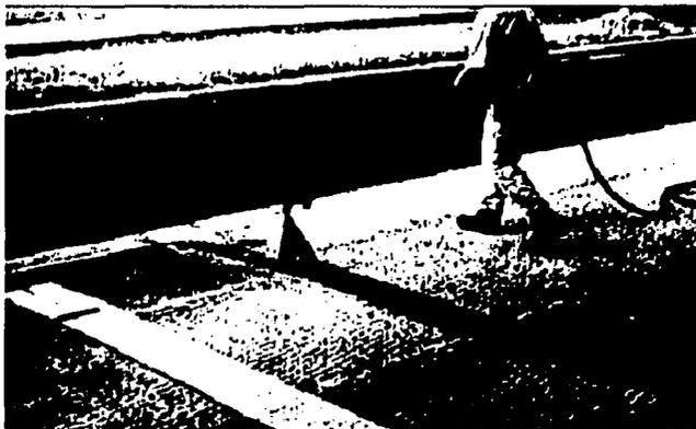
*Riego manual de asfalto con boquilla*
