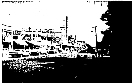
EDIFICACIONES SIN ORDEN, CONTAMINACION VISUAL
