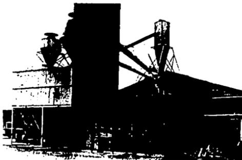
Figura 2.12 Incinerador de cámara múltiple del tipo en línea para 1,000 lb/h (Orban Lumbre Co., Pasadena, Calif.).
