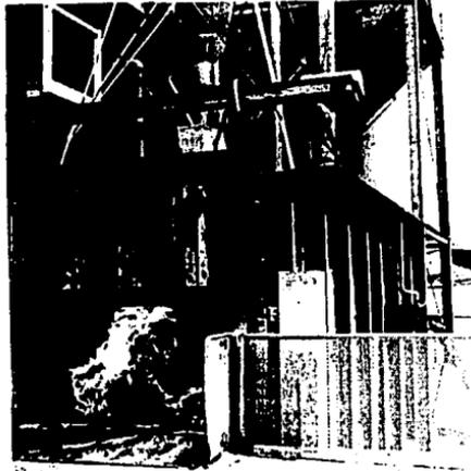
Figura 2.10 Incinerador de cámara múltiple de residuos de madera el tipo en línea, para una capacidad de 2,000 lb/h (Metro Goldwyn Mayer, Inc., Culver City, Calif.).
