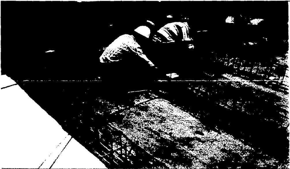
A.4 Se guía la dirección del cable de presfuerzo.
