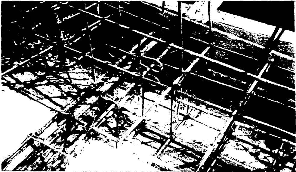
A.8 Anclaje pasivo fijo y acero de refuerzo colocado.
