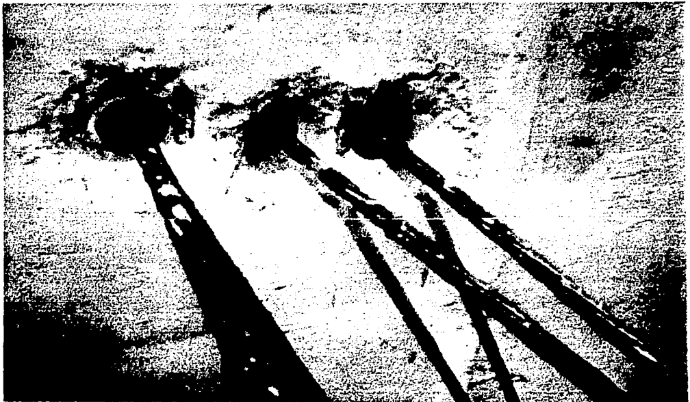
A.22 Anclajes activos rectos tensados.
