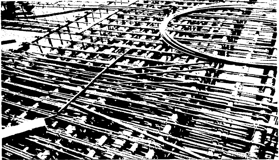
A.9 Salida de cables intermedios.
