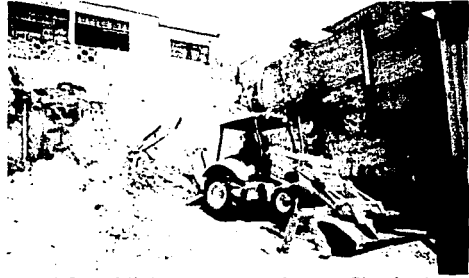
Foto 3.26 Mini – retroexcavadora perfilando el portal de acceso.
