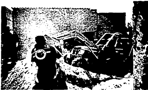
Foto 3.31 Escuadrón de minas acomodando el material que se utilizará en el relleno de las minas.
