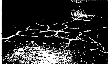
Foto 3.37 Grietas de tensión que se forman por la contracción que sufre el relleno.
