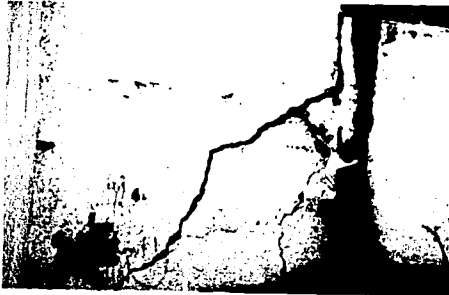
Foto 3.5 Tomada cuatro meses después con respecto a la anterior, y se puede observar el avance de los daños.
