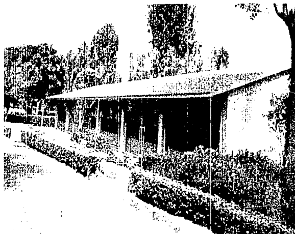
Fachada de los talleres.
