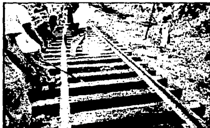
Fig. 4.1. Tendido de vía por medios manuales.
