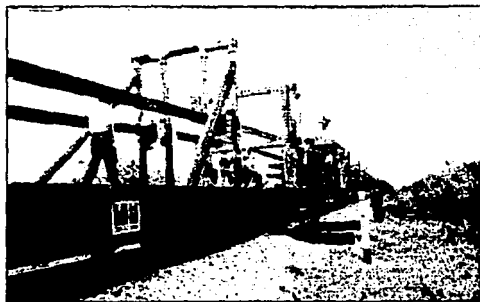
Fig. 3.9. Descarga de riel en el tramo por rehabilitar.
