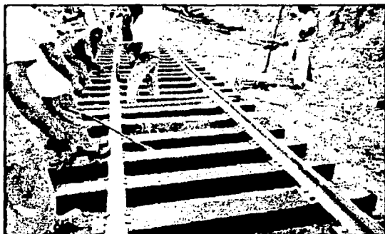
Fig. 2.17. Fijación del riel en el durmiente.
