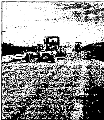
Fig. 3.12. Retiro de balasto.
