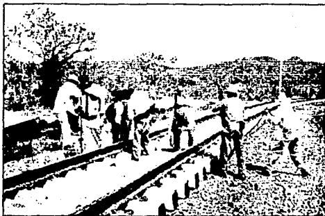
Fig. 3.15. Espaciamiento del durmiente.
