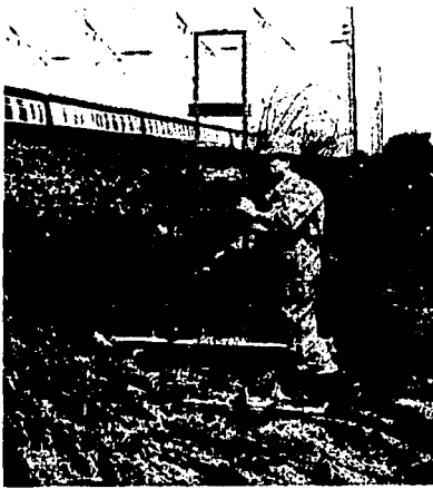
Fig. 3.31 Nivelación de la máquina de perforación.
