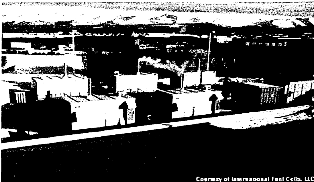
Figura 3. Instalación de varias celdas de combustible de ácido fosfórico en Alaska por parte de International Fuel Cells en colaboración con el Departamento de Defensa norteamericano
