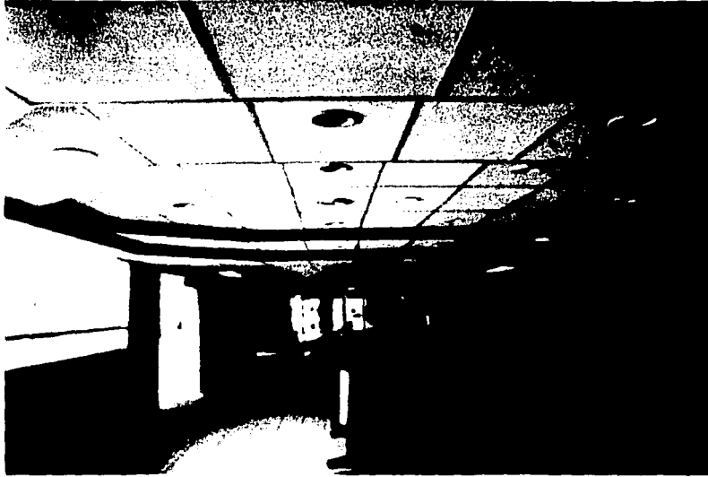
La fotografía 16 indica el plafón terminado en el área de imagenología
