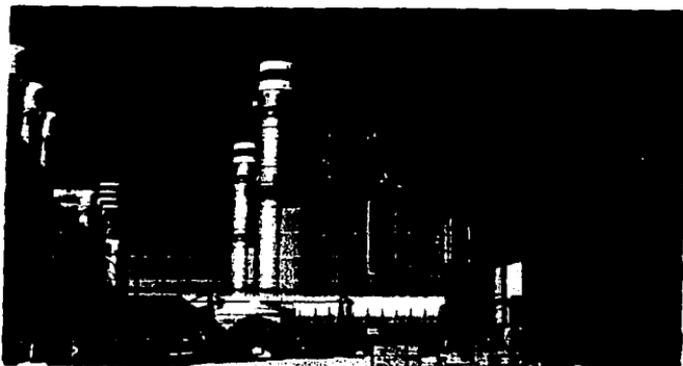
SE OBSERVA LA TUBERIA DEL HRSG, QUE ES UNO DE LOS ELEMENTOS PRINCIPALES EN EL CICLO COMBINADO
