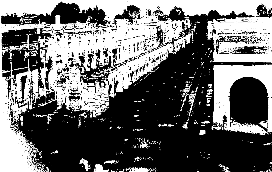
Vista de la calle de Salto del Agua en el año de 1870, donde se observa el acueducto de Belén y la fuente, mismos que abastecían de agua a la zona.
