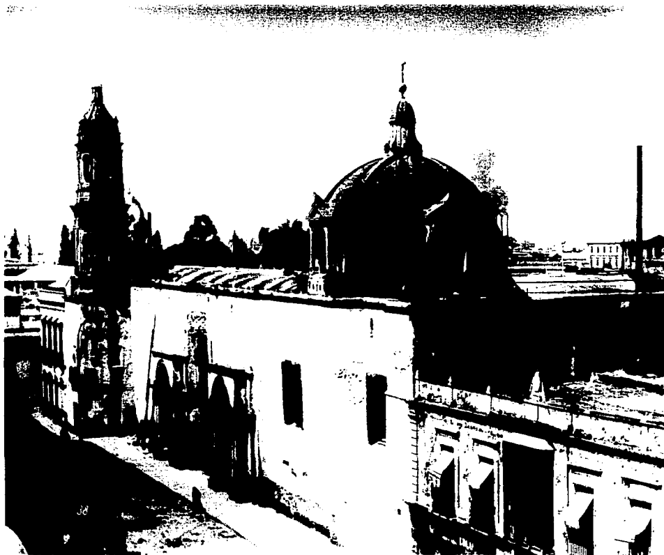
Exterior de la Iglesia de San Juan de la Penitencia, misma que fue demolida para edificar en su lugar la actual Iglesia del Buen Tono.
