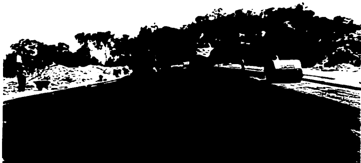
FIGURA 22. Compactado de la Carpeta por Medio de un Rodillo Liso
