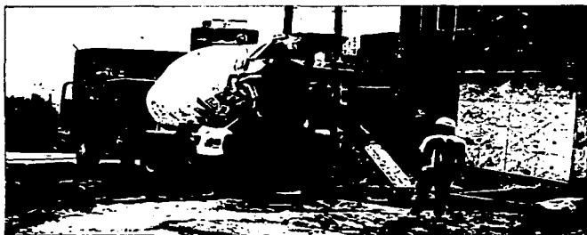
Fotografía 34: Vaciado de mezcla por las cámaras: L-6 y L-13 respectivamente
