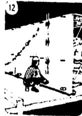
13.-Colocar el cierre de muro sobre el primer túnel, fijándolo con los seguros.
