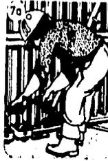
8.-Deslizar manualmente el túnel sobre la plataforma de desencofrado y fijar el triángulo de levantamiento.
