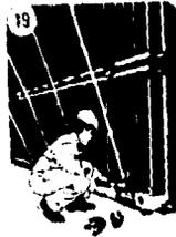
20.-Volver a colocar las fronteras o las orillas en posición de cimbrado, fijándolas con sus seguros.
