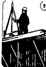
9.-El medio túnel es levantado por la grúa y colocado en su nueva posición.
