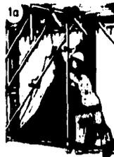
2.-Los tornillos de sujeción o pasadores, son retirados y colocados detrás de la trabe horizontal, como medida de seguridad.
