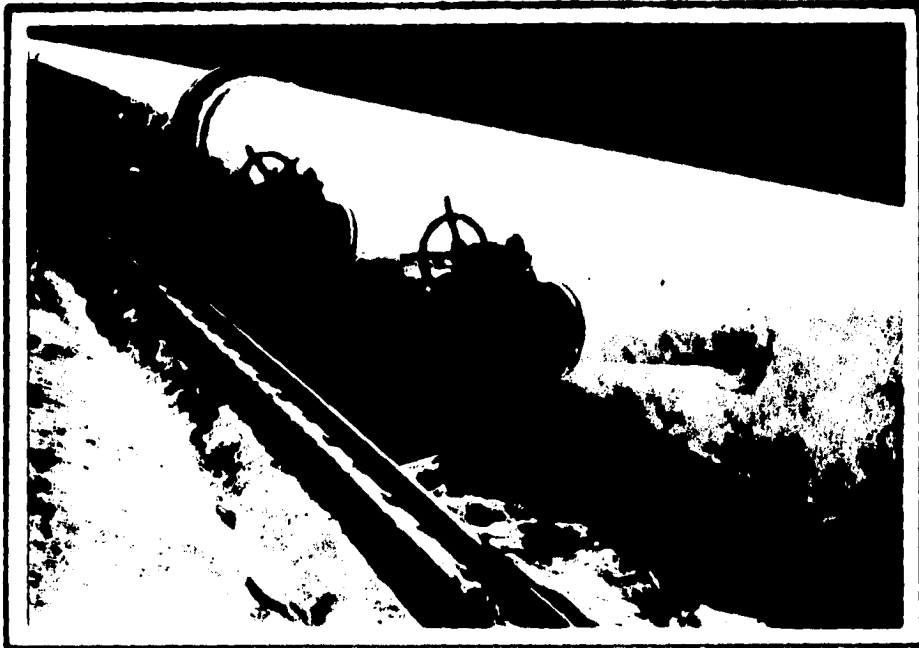
FOTOGRAFIA III.7.-Válvulas de desfogue "macho" en nivel intermedio Elev.1344.
