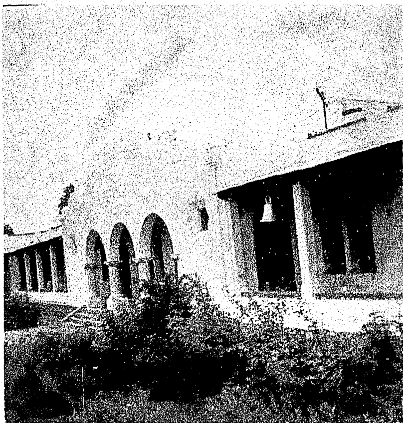
Fachada principal de la escuela NORMAL RURAL DE SALAICES.
