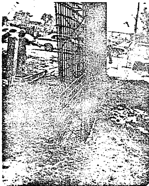
FOTO No. 4 INTRODUCCION DE ACERO (DONDE NO EXISTE BROCAL)
