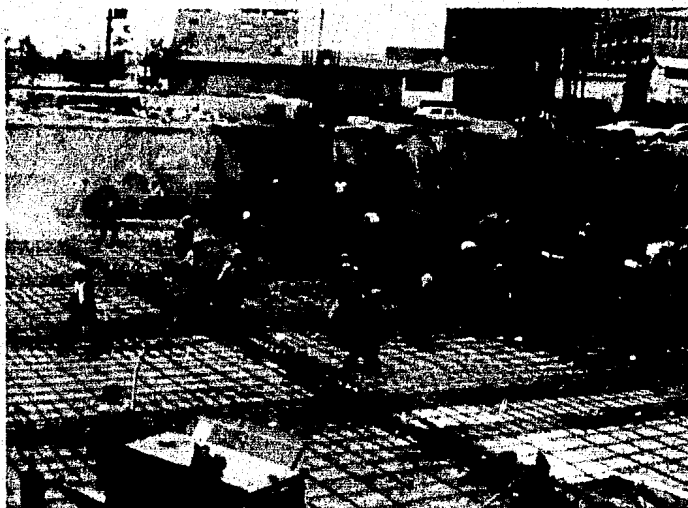
ARMADO DE LOSAS EN CIMENTACION.
