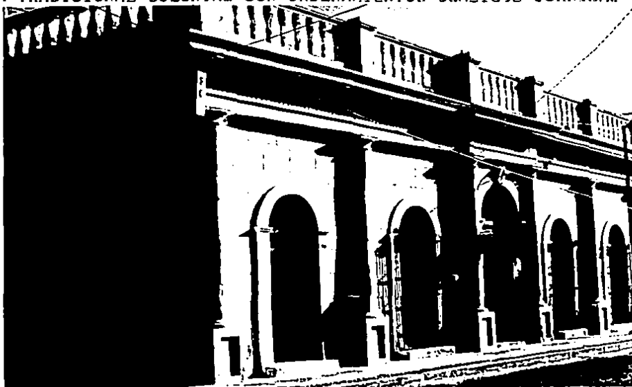
EDIFICIO DE CORREOS
