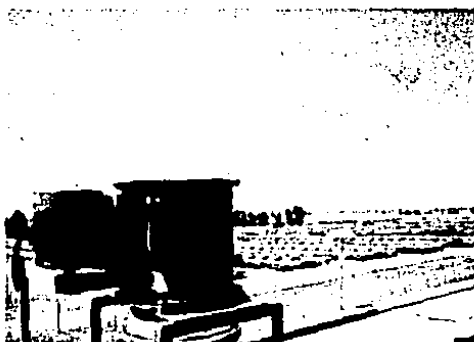
Figura 4.2 Ventilador tuboaxial para la extracción de humos de una caseta de prueba de motores.
