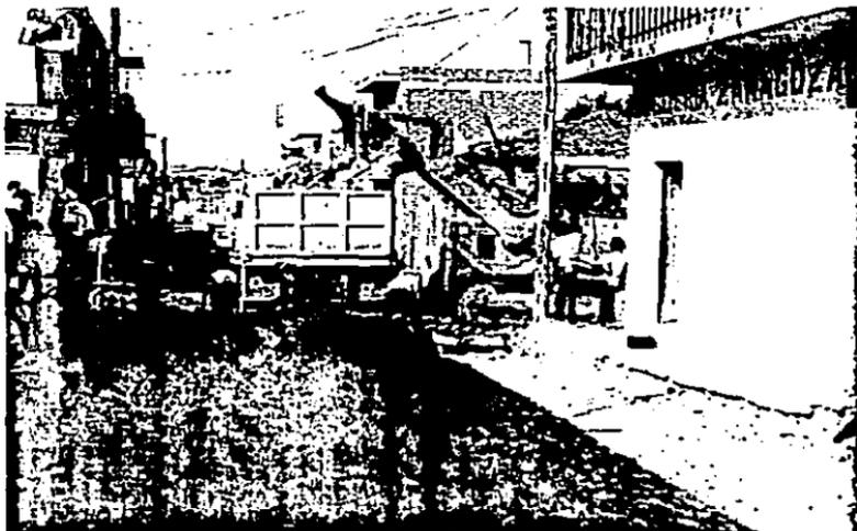
Una vez colocado todo el empedrado se procede a colar las losas de concreto sobre él, las cuales llevan el espesor de 15 cms mencionado y están hechas de concreto con resistencia de 200 kg/cm<sup>2</sup>. Un tramo de calle parcialmente acabado se puede observar en la fotografía que a continuación se muestra; como se mencionó en la introducción estas losas llevan un tamaño máximo de 3 x 2.50 metros.
