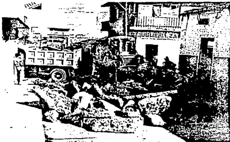
En esta fotografía se puede observar lo que se decía acerca del empedrado sin juntear. Se puede notar como salieron bloques de pavimento con un espesor mayor a los 20 cms, pero en este caso la falla se presentó
