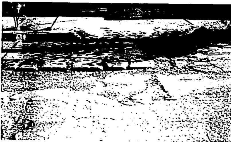
Otro detalle que se debe notar es que el asfalto es el único dañado y la banqueta está casi intacta por lo que se deduce que la falla ocurrió en los lugares donde las cargas eran lo suficientemente altas como para provocar los asentamientos en el material y el hecho que los asentamientos más notorios ocurriesen en los lugares cercanos a las banquetas que es donde de los vehículos están como cargas estáticas comúnmente, ayuda a la creencia
