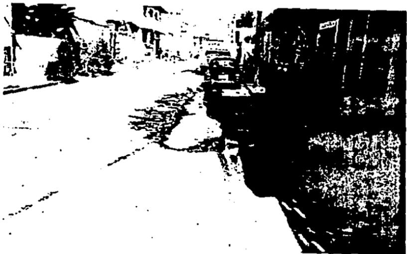
En el acercamiento del mismo lugar se puede ver el asentamiento en la capa ocasionado por éste error en la compactación. Es de notarse el daño provocado en la carpeta por esta falla, un daño que además de molesto, puede llegar a ser peligroso por razones de seguridad de vehículos y peatones.
