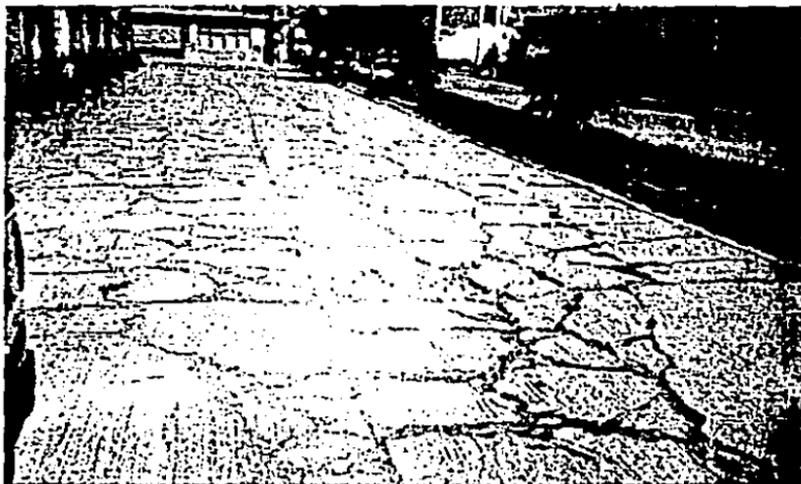
Las últimas fotografías muestran que no sólo el tener una base adecuada es sinónimo de un buen diseño. Aquí se observa la existencia de grietas provocadas por cambio de temperatura; estas grietas aparecieron porque las losas eran demasiado grandes para el espesor, sumado a esto las juntas
