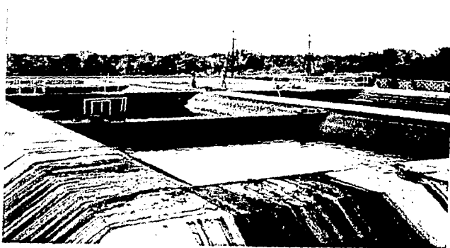
Foto 6.- Presas de Separación Crudo - Agua.
