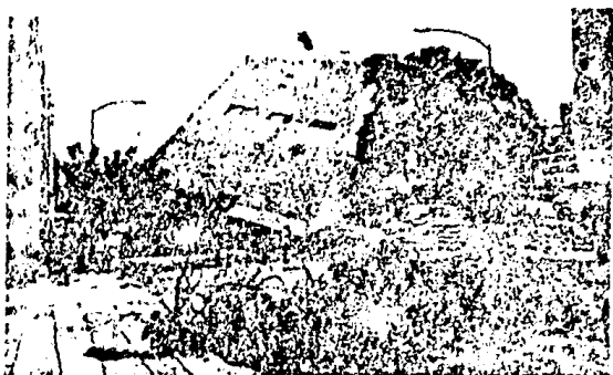
Fotografías 15 y 16. Edificio en Abraham González y Barcelona. Edificio en esquina con excesiva torsión, que ocasionó la falta trágica de las columnas de fachada del primer piso, lo cual provocó el vuelco del edificio.
