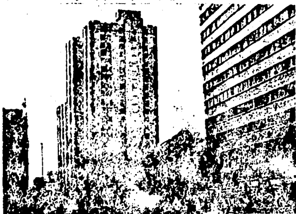
Fotografías 1 y 2. Edificio Pino Suárez. Se trata de un edificio de 20 pisos, con periodo natural aproximadamente de 2 segundos; típica falla por resonancia.
