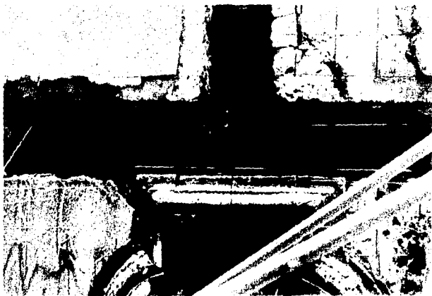
CUARTEADURAS DE LAS COLUMNAS
