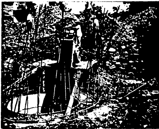
Figs. 10.2.15 Relleno del cuerpo del cilindro.
