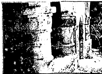
Deterioro en las columnas
