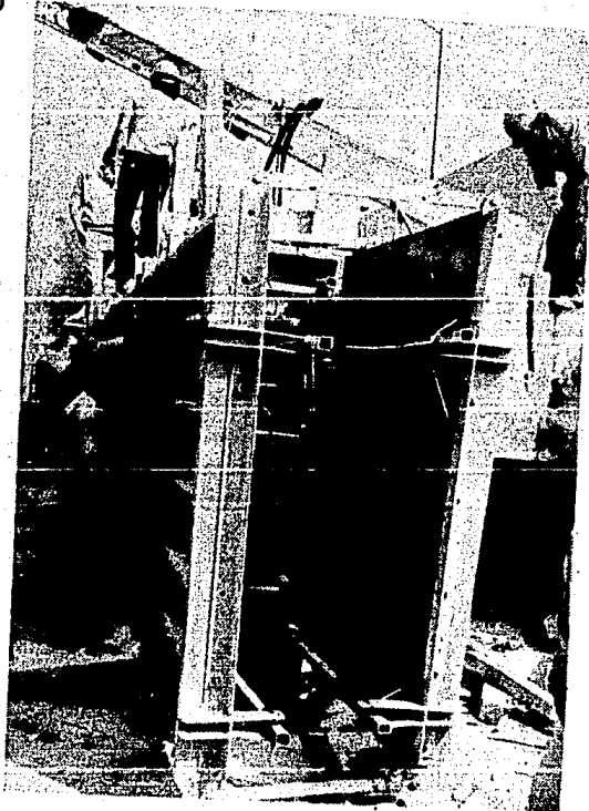
FOTO 5.1 CAMA PARA TENDIDO DE REFUERZO Y CIMBRADO DE TRABE PRESFORZADA.
