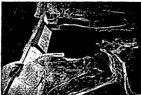
PRESA INTERNACIONAL LA AMISTAD, SOBRE EL RIO BRAVO VISTA DE LA CORTINA DE MAMPOSTERIA (SECCION VERTEEDORA) Y DE PARTE DE LAS SECCIONES DE TIERRA
