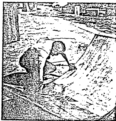
Fig.7.6 Expulsión de la solución de detergente con una espátula de plástico.
