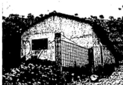
La cubierta con circulación de aire al interior de los cuartos permite climatizar el espacio.
