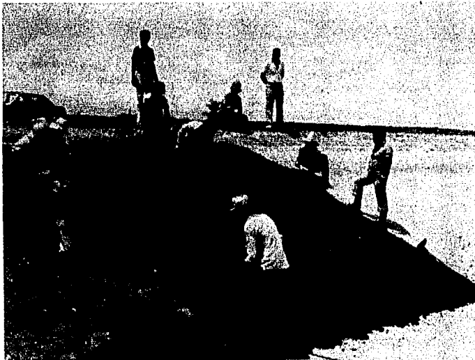
Figura 6.9.- Colocación de la mezcla asfáltica en talud.
