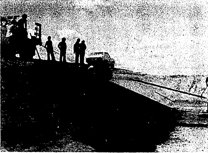
Figura 6.12.- Rodillado de la mezcla asfáltica sobre el talud.
