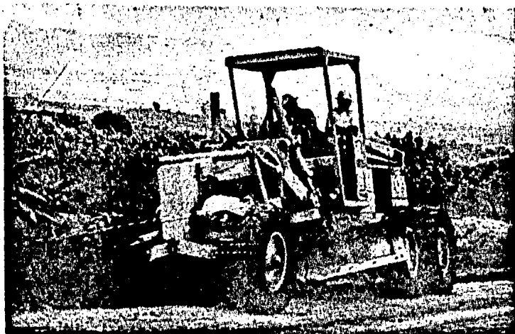
FIG. No. 17 Limpieza de Cunetas
