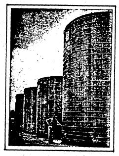
Figura I.3 . Tanques de duelas de madera para almacenar aceite .
