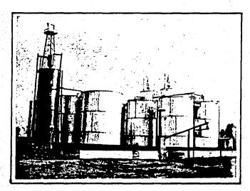
Fig. 1.4. Tanques atornillados de almacenamiento y para separación de agua.
