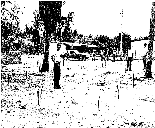
Traza de la obra realizado en mayo de 1982 por un grupo de elementos de la Brigada de Trabajo del Taller y voluntarios del pueblo.
