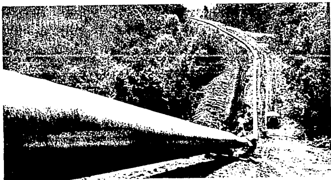
Armado de la tubería.
