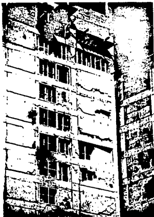
Fig. 3.1 Efecto de los muros de relleno.
