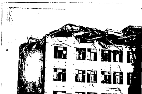
Fig. 3.21 Daño en pisos superiores ocasionado posiblemente por algún modo superior de vibración.
