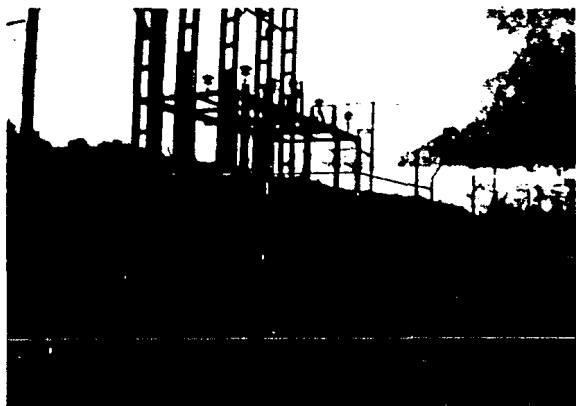
Fig. 4.2.e. Puesto de subseccionamiento.
