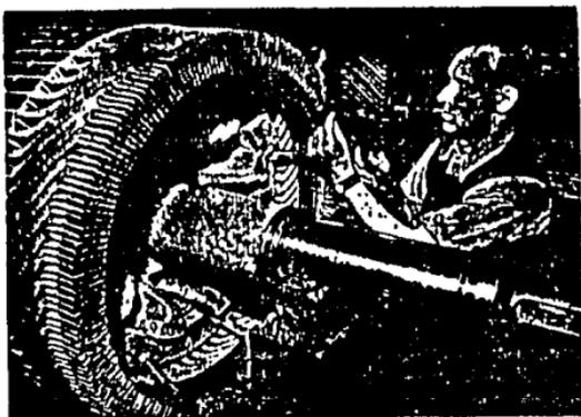
Fig. 3.4 Motor de 500 H.P. recubierto con cintas de terylene barnizado, que actúa como aislante.
