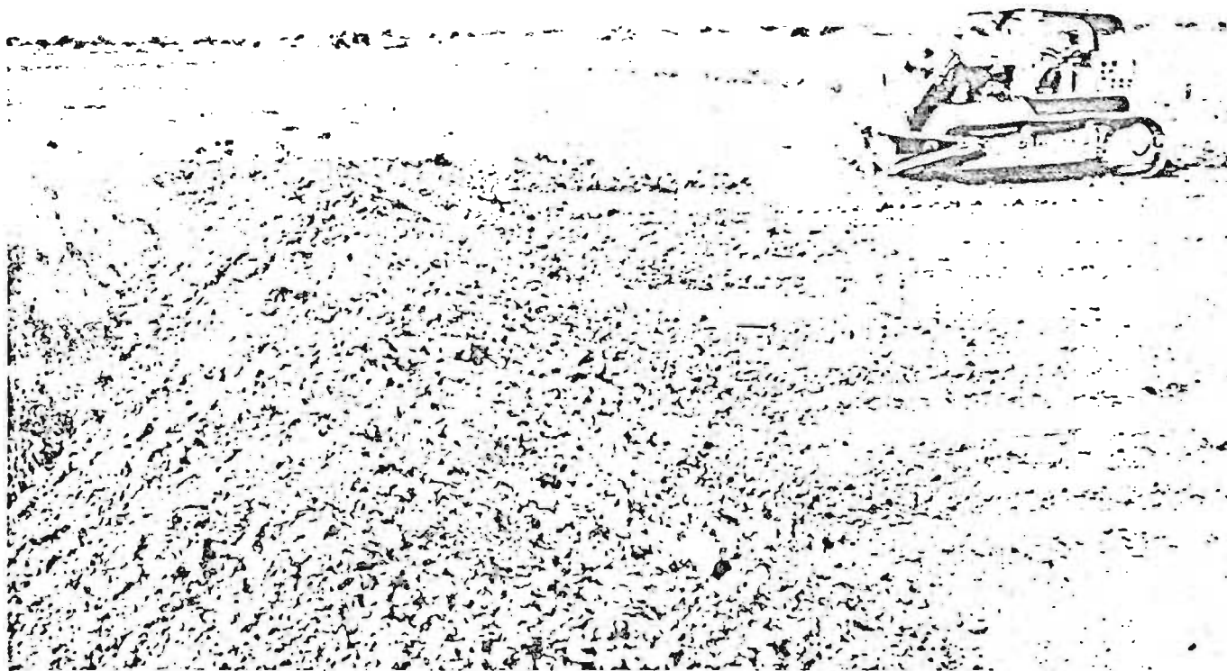
Limpia superficial y despalme en la zona de construcción.
