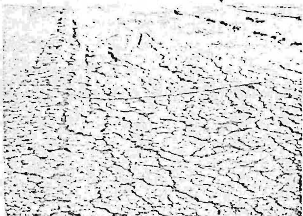
Falla estructural generalizada.
