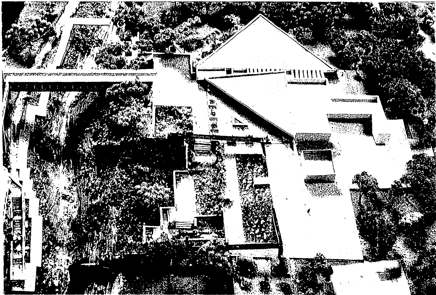
FALLA DE ORIGEN
