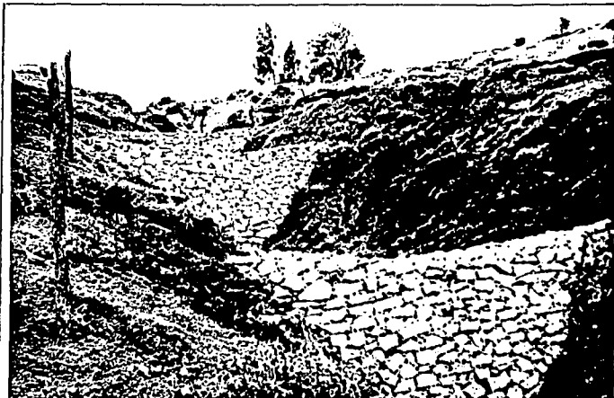
Foto 11. Presas de gabiones empleadas para aminorar los niveles actuales de pérdida de suelos, en las cercanías de La Concepción (foto de S. Nolasco)
