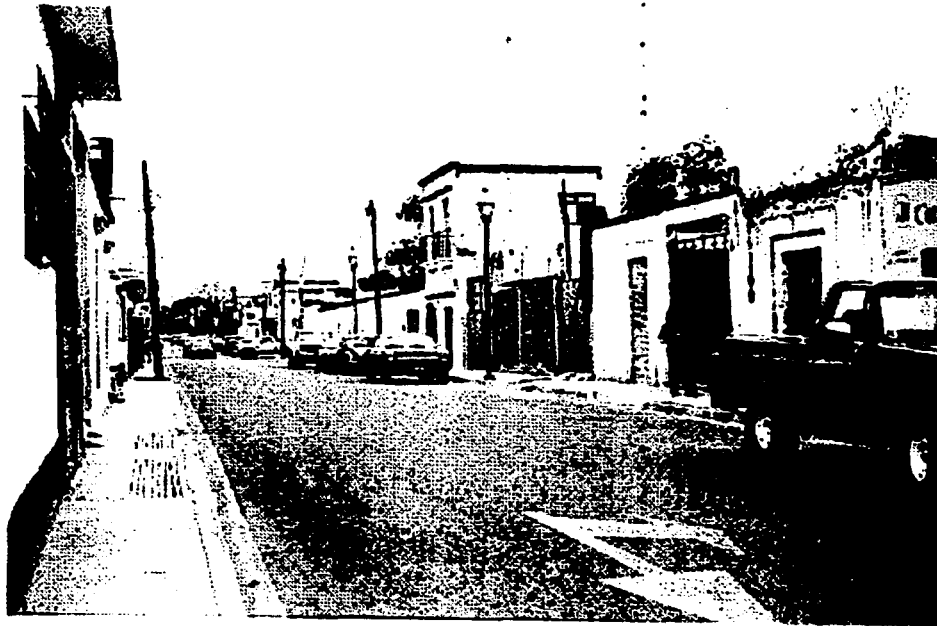
FALLA DE ORIGEN
