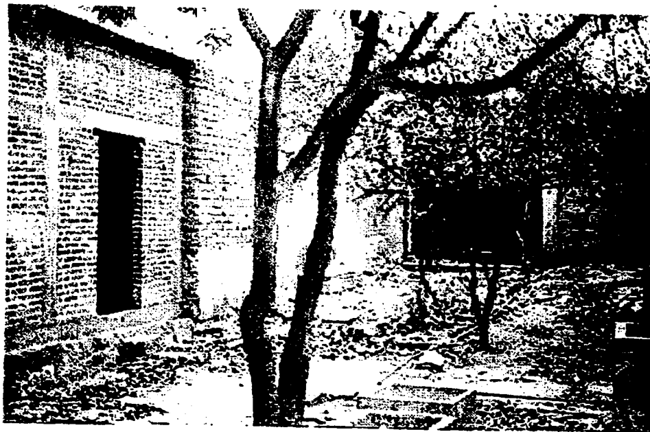
FALLA DE ORIGEN
