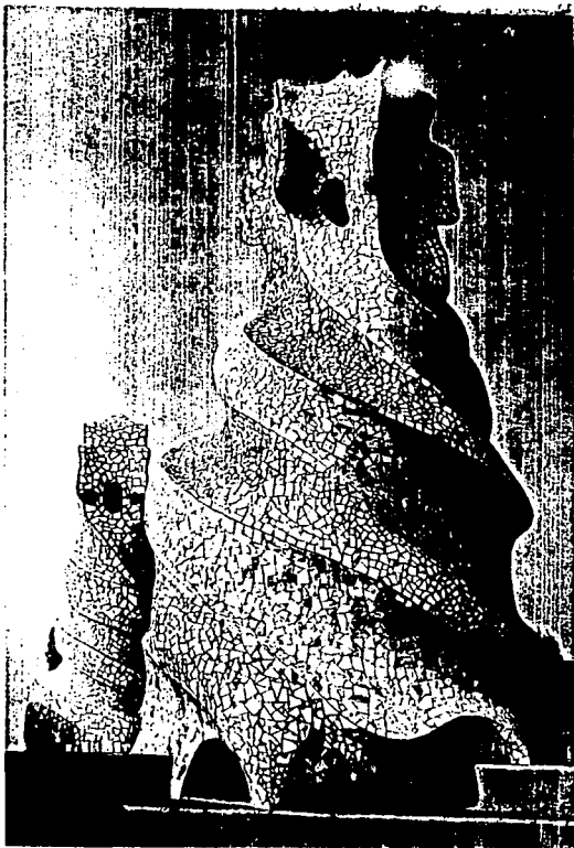
Torre de ventilación, Palacio Güell, Barcelona. Antoni Gaudí
