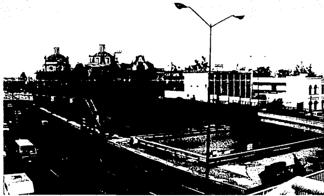
6 Vista aerea desde el segundo puente peatonal hacia la iglesia.
