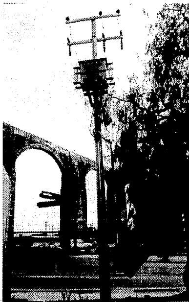
Figura p) Vista del Poste y Transformador
