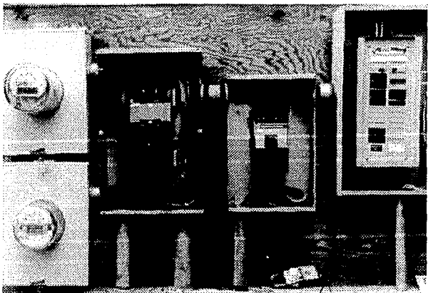
Figura t) Detalle de Tablero Principal
