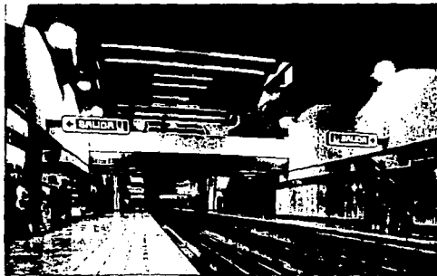
ESTACION PATRICIO MÉNDEZ LINEA N° 9
