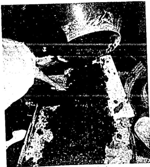
*Vaciado de la mezcla de la revoladora*
