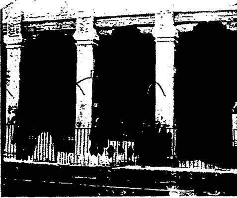
Claustro de la Concepción, planta alta. En la fotografía siguiente se observa esta galería al fondo. Cabe señalar que este claustro conservaba su disposición original en 1861, es decir, las celdas, las capillas y el estanco se hallaban en su espacio y tenían un solo dos lados con galería de columnas, sin arcos.
