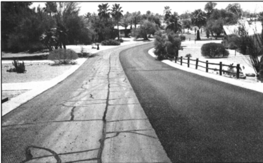
Foto: Sobrecapa con hule-asfalto en caliente, condiciones antes de colarla en el lado izquierdo y capa colocada en el lado derecho.
