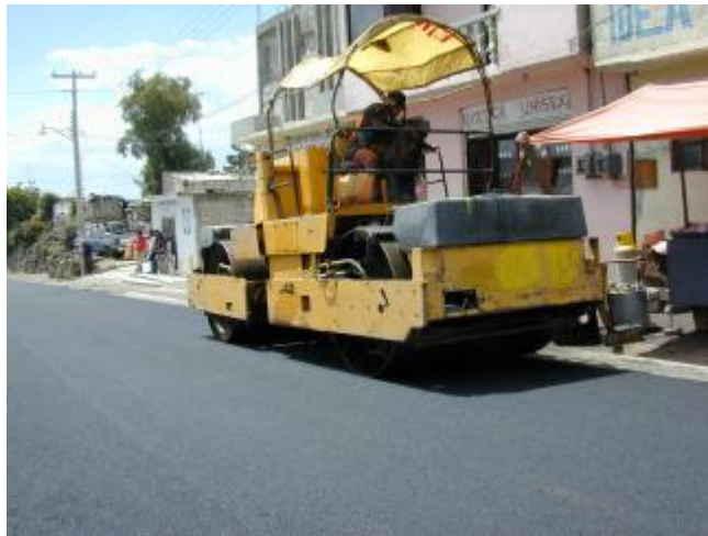
Carretera: San Salvador el Seco – Azumbilla Tramo: San Salvador el Seco – “T” Azumbilla Subtramo: del km 0+000 al km 0+700 (tramo9 de prueba) Fecha de construcción: Julio de 2001
