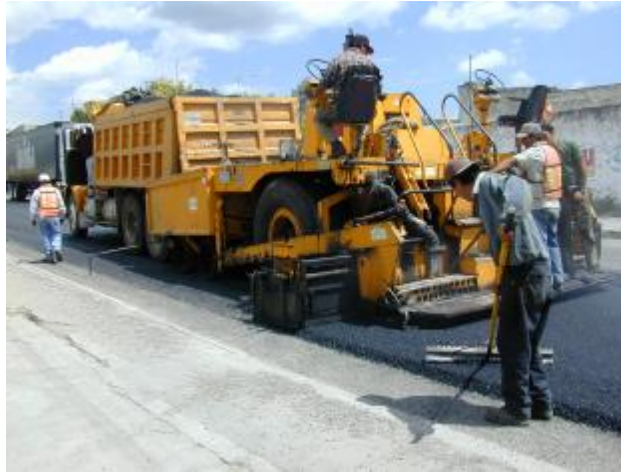
Carretera: San Salvador el Seco – Azumbilla Tramo: San Salvador el Seco – “T” Azumbilla Subtramo: del km 0+000 al km 0+700 (tramo de prueba) Fecha de construcción: Julio de 2001
