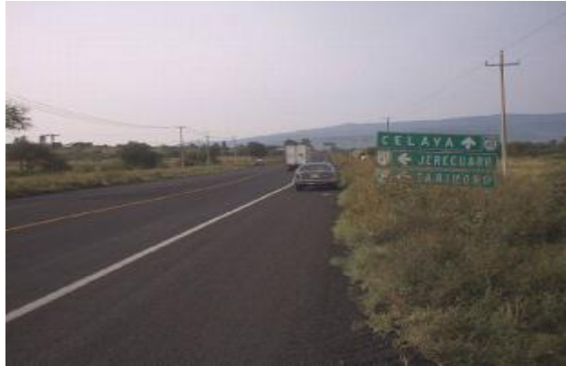
Carretera: Querétaro - León Tramo: Lím. Edos. Qro./Gto. - Celaya Subtramo: del km 13+500 al km 29+100 Fecha de construcción: octubre de 2002
